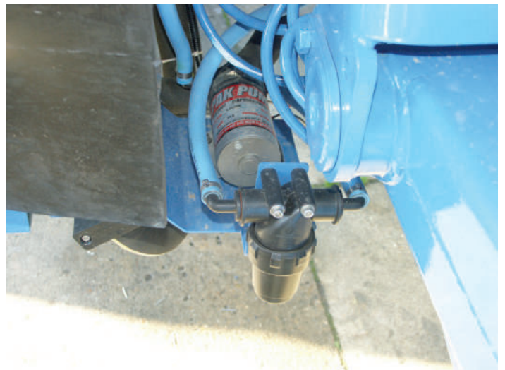
Pompe de fond de cuve
